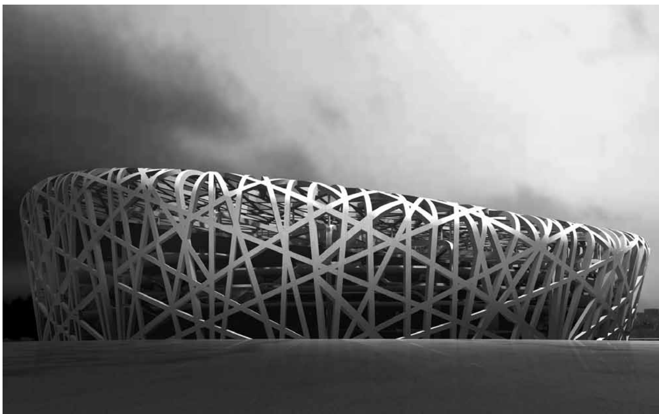
La structure "en nid d'oiseau" du Stade National de Pékin, construit en 2003.
