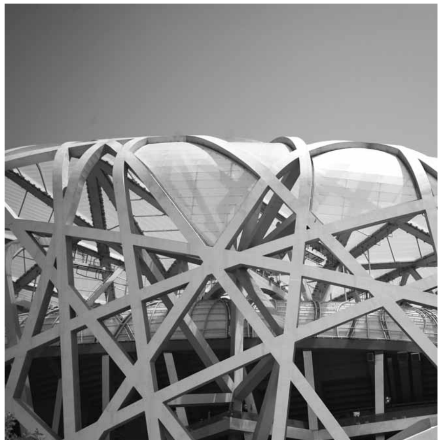
Détail de la structure du Stade National de Pékin.
