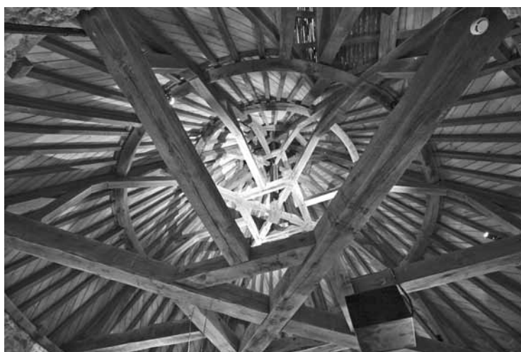
La charpente du donjon du château de Blandy-les-Tours (F), construit au XIV e siècle.
