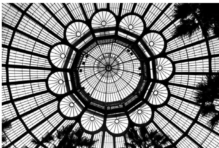
La structure métallique d'une serre du château de Laeken, à Bruxelles.
