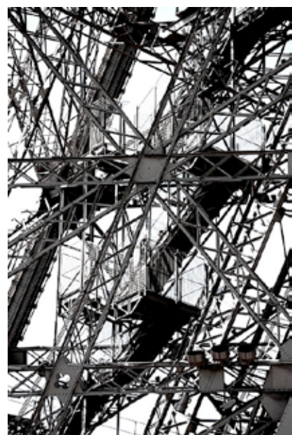
Détail de la structure de la Tour Eiffel.
