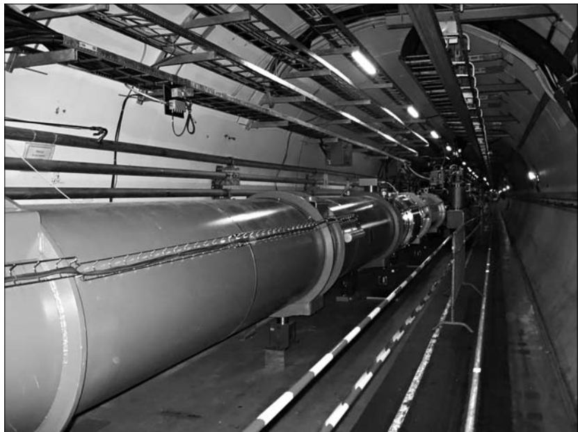
L'acceleratore di particelle del CERN di Ginevra.
